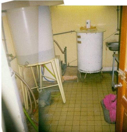
Le système de traitement de l'eau de l'hémodialyse à Viet Tiep.
